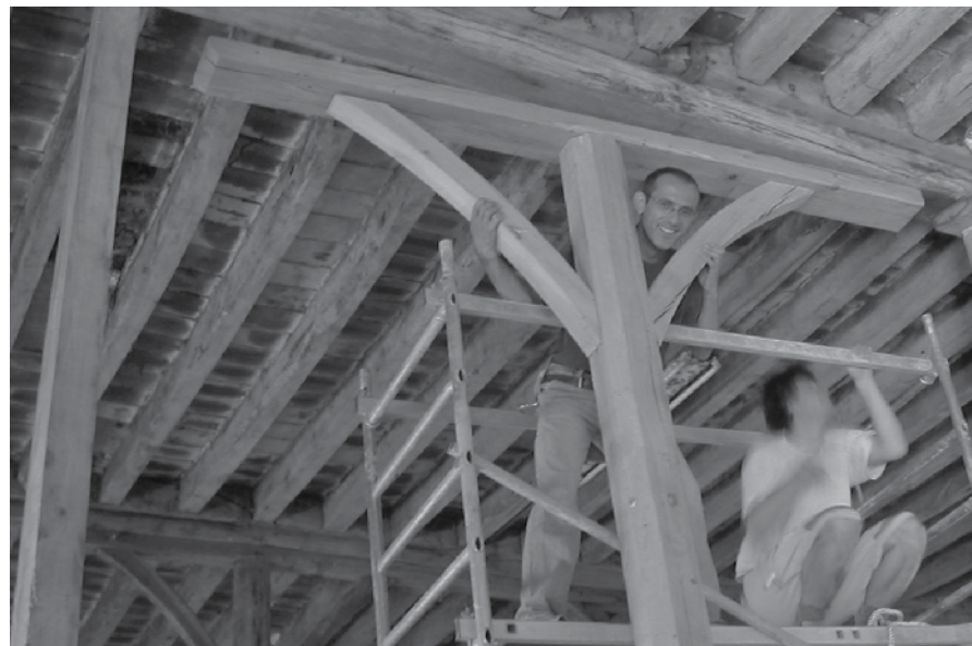
Pose de 2 nouveaux poteaux du rez-de-chaussée de l'aile Nord
